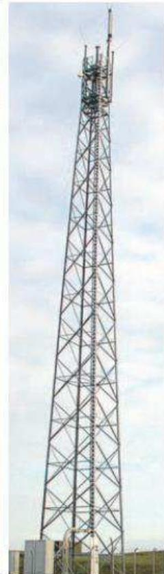
So sieht ein neuer Stahlgittermast mit Digitalfunkantenne aus – oft werden vorhandene Masten genutzt.
